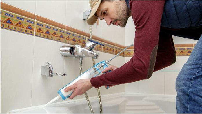
**Damit in Materialübergänge, Ecken und Ränder im Bad kein Wasser eindringt, erhalten Fugen eine Silikonfüllung per Kartuschenpistole. Der glänzende Dichtstoff schützt dabei dank seiner pilzhemmenden Stoffe vor Schimmelfall im feucht-warmen Klima des Nassbereichs. Wer auf emissionsarme Produkte mit dem EMICODE®-Siegel zurückgreift, hält die mögliche Belastung durch das Silikon weitestgehend gering.**
